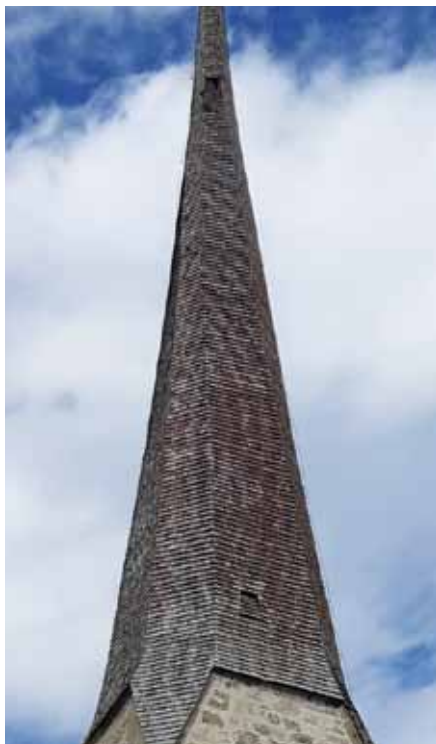
Aktueller Zustand vom Kirchturm Pfarrkirche St. Peter
